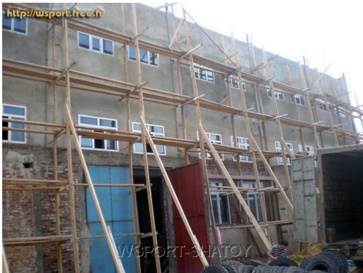
Строительство нового комплекса Школы им. братьев Сайтиевых
