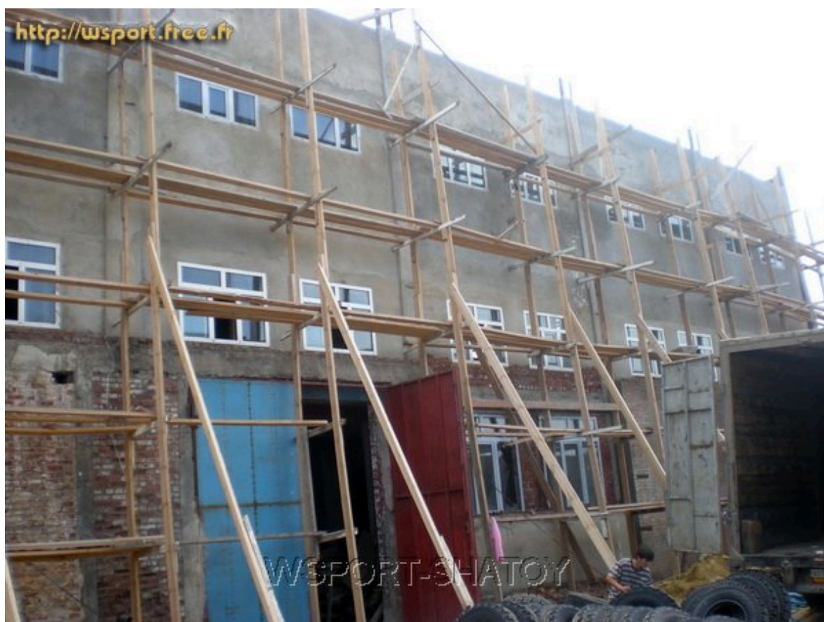
Строительство нового комплекса Школы им. братьев Сайтиевых
